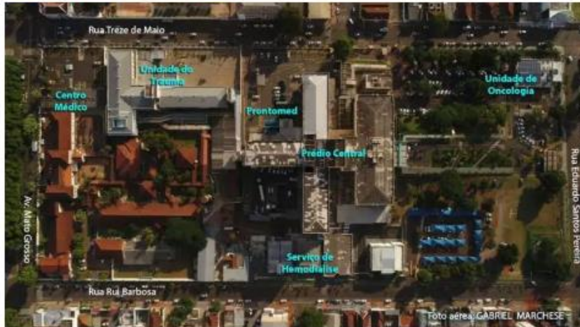
Estrutura arquitetônica do complexo hospitalar da Santa Casa contribui para as ações de enfrentamento à covid-19. (Foto: Gabriel Marchese)
